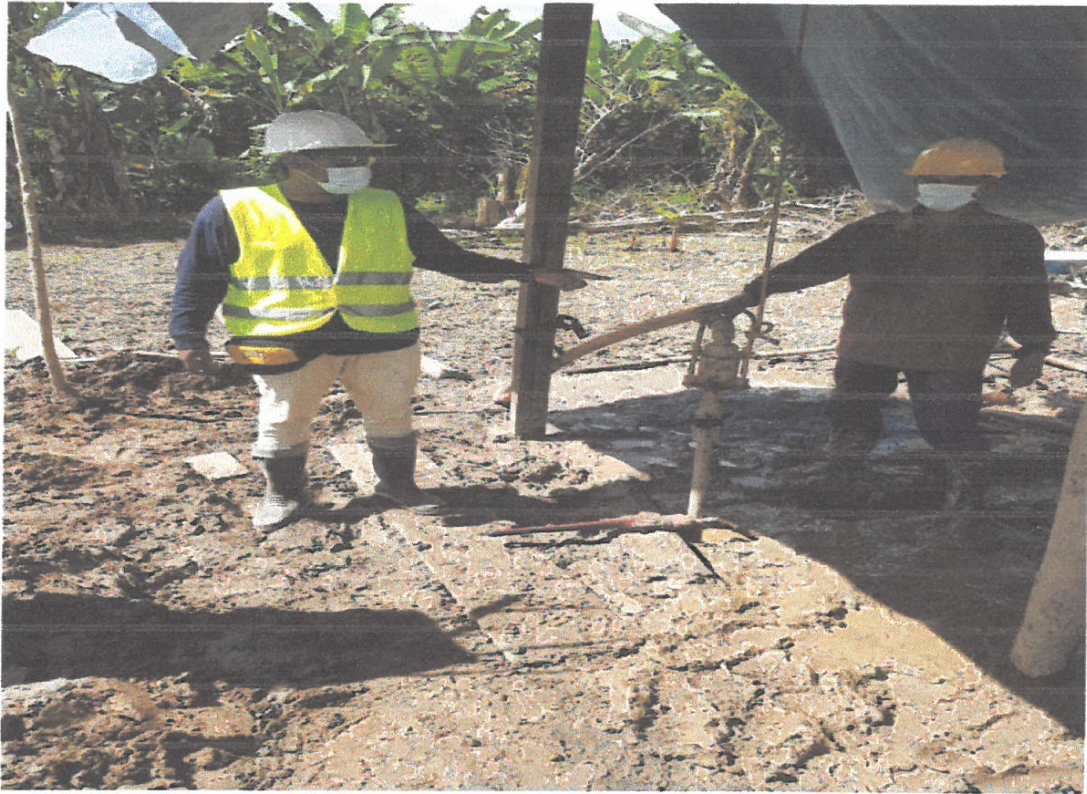
FOTO N°09: supervisión de los trabajos de perforación del pozo artesiano.
