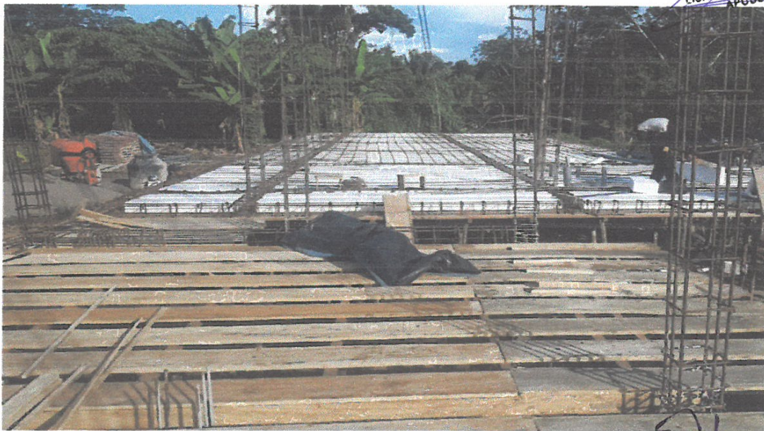
FOTO N°02: Se observa el trabajo de encofrado, colocación de Tecnopor y habilitación de acero para la losa aligerada.
